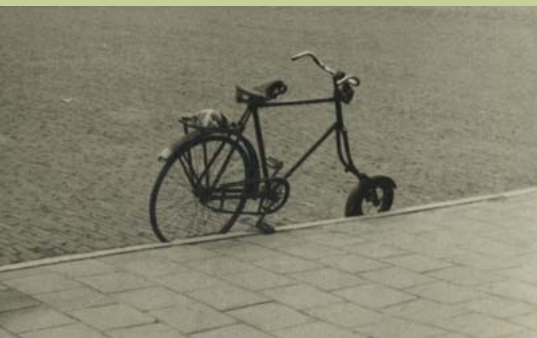
Autopedwieltje als voorwiel om in beslagname van de fiets te ontlopen, 1943
